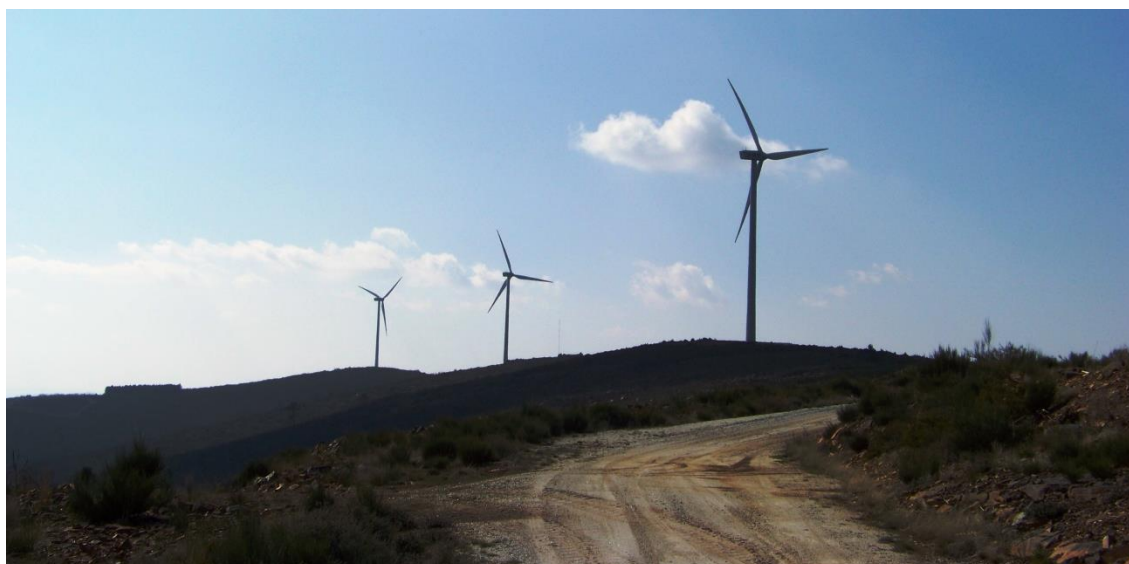
Figura 21 - Aerogeradores implantados em 2008 na crista mineralizada da Pedrada
