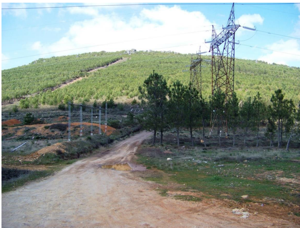
Figura 20 - Linhas de alta e muito alta tensão na base sul do cabeço da Mua
